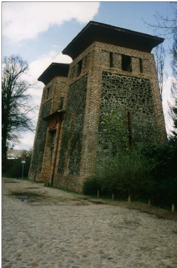
Abb. 8: Einmalig in Mecklenburg-Vorpommern sind die den ägyptischen Pylonen nachempfundenen Glockentürme
