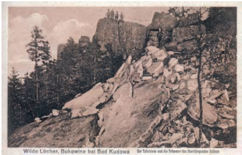
Ryc. 7. Überhängende Stein po zawaleniu się. Uwagę zwraca ogromne nagromadzenie ostrokrawędzistego materiału blokowo-gruzowego. Źródło: prywatne zbiory Petra Zimy.
