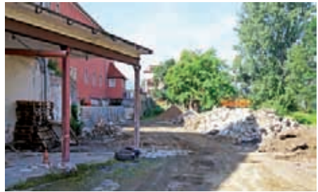
Fot. 1. Rozpoczęcie budowy promenady pomiędzy rzeką Kamienną a budynkiem Muzeum.
