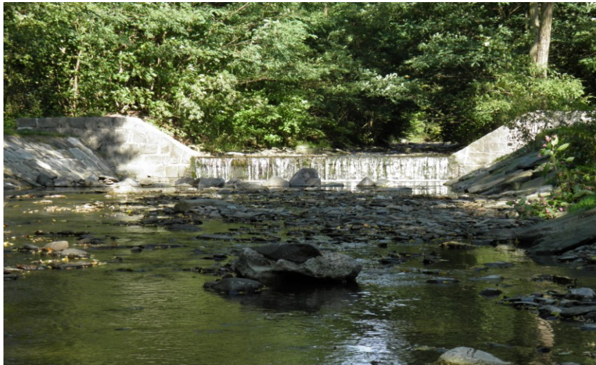
Obr. č. 14: Čtvrté odběrné stanoviště (Arnošová, 2011)
