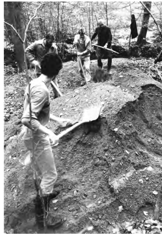
Abb. 10: Gemeinsam verfüllen am 9. November 1989 Mitarbeiter der Biologischen Station Serrahn und des Fliegerhorstes Neubrandenburg der Nationalen Volksarmee (NVA) den Graben am Bixbeerenbruch zum Schweingartensee (Foto: Bartocha).
