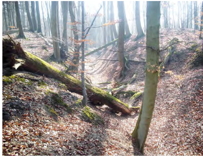
Abb. 6: Verbindungsgraben zwischen Schweingartensee und Wutschendorfer Pöhle mit beidseitigem Aushubwall (Foto: K. Kaiser, März 2011, Blick nach Süden). Der Graben ist maximal ca. 5 m gegenüber der natürlichen Umgebung eingetieft. Er führt kein Wasser und seine Hänge sind teilweise mit Altbuchen und -eichen bestockt.
