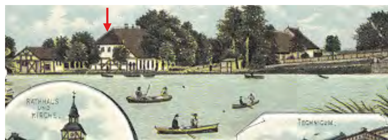
Abb. 5: Der Standort der Domjüchmühle auf dem Ausschnitt einer kolorierten Ansichtskarte aus dem Jahr 1899 (vgl. auch KAISER et al. 2015, hier Abb. 5). Das mutmaßliche Mühlengebäude am Domjüchsee ist mit einem roten Pfeil markiert.
