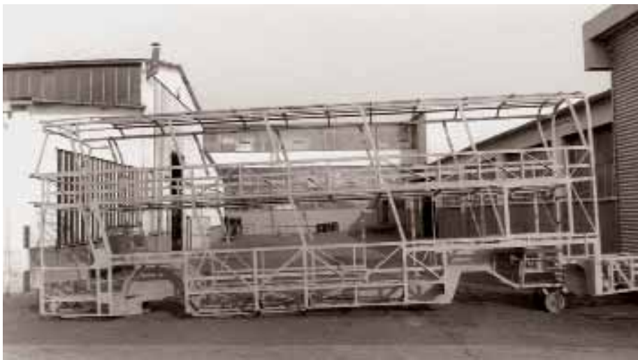
Gerippe des Prototyp-Vorderwagens im Hof des Neoplan-Werks Stuttgart. Am Heck des Unterdecks erkennt man das Gerippeteil, das später den Motor aufnehmen wird.
