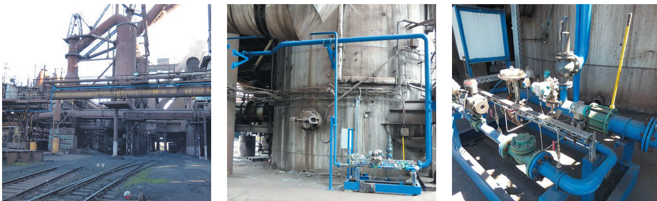
3. ábra: Oxigénbekeverő rendszer az I. sz. nagyolvasztó léghevítőinél
